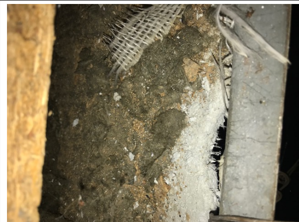
Déclaré - D8 : RDC - Faux plafond - 1- (Présence d'amiante)
