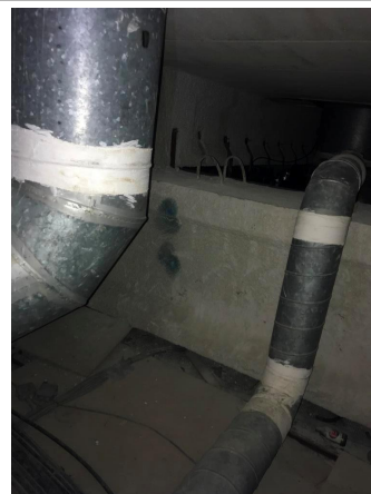
Prélèvement - P2 : 1 er / comble plenum - Enduit projeté - EP- (Présence d'amiante)
