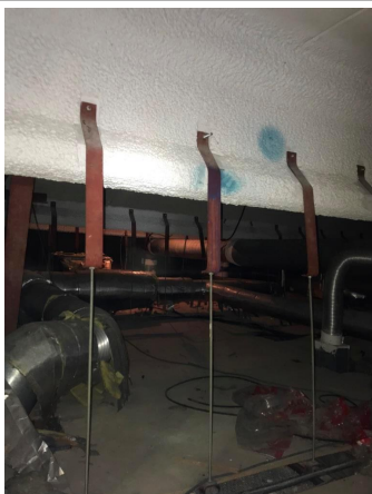
Prélèvement - P1 : 1 er / comble plenum - Enduit projeté - EP- (Présence d'amiante)
