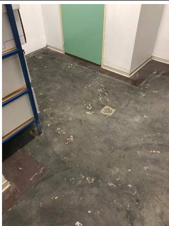
Déclaré - D5 : RDC / LOCAL 522 - Dalle de sol - AC2- (Présence d'amiante)
