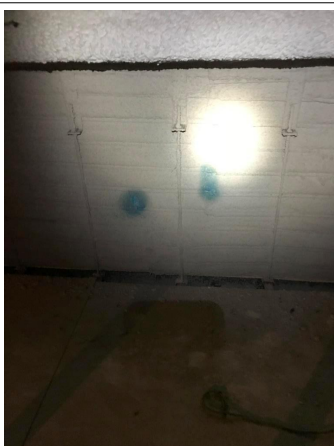
Prélèvement - P3 : 1 er / comble plenum - Enduit projeté- (Absence d'amiante)
