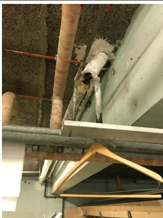
Déclaré - D9 : SOUS SOL - Conduit - EP- (Présence d'amiante)
